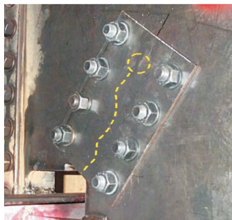
图16 安装裂纹盖板示意 [18]
